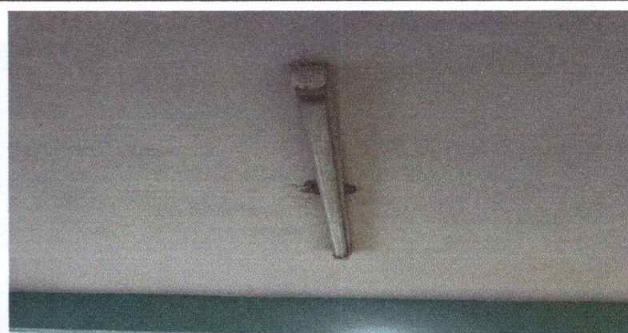
Foto 2: Sustrucción de plafoneras
