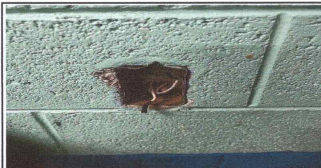
Foto 6: Reparación de cableado eléctrico
